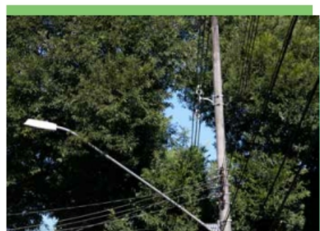
Figura 40 – Túnel em rede compacta
