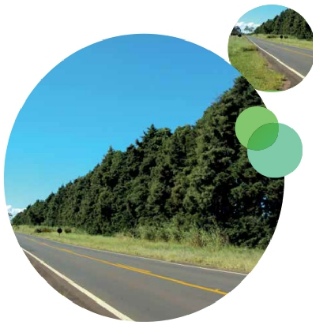
Figura 3 – Aspecto de barreira quebra-vento protegendo rodovia
