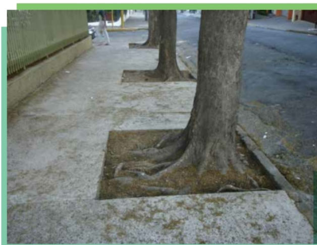
Figura 45 – Canteiro ampliado e piso de calçada refeito
