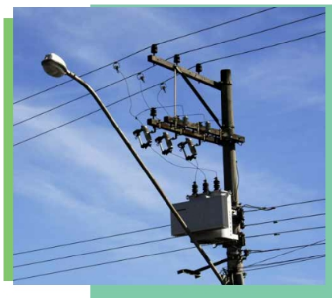
Figura 16 – rede de distribuição primária básica - MT
